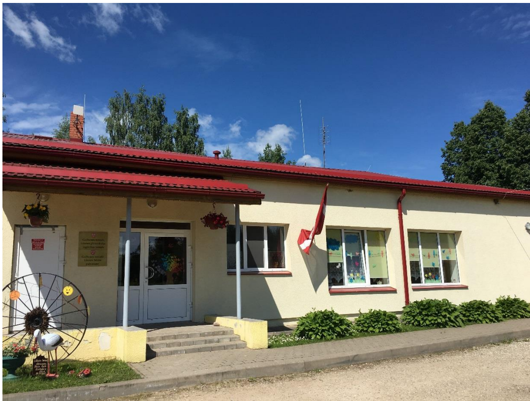
Att. Nr.1 Ēkas galvenā fasāde
