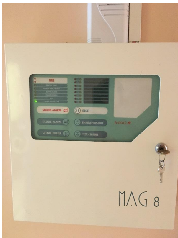
Att. Nr.15 Ugunsdzēsības trauksmes sistēmas vadības bloks
