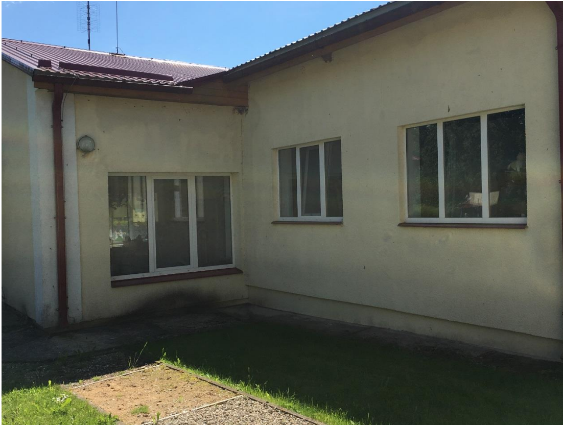
Att. Nr.3. Mitrums nonāk ēkas sienā nepilnīgas lietus ūdens novadišanas dēļ
