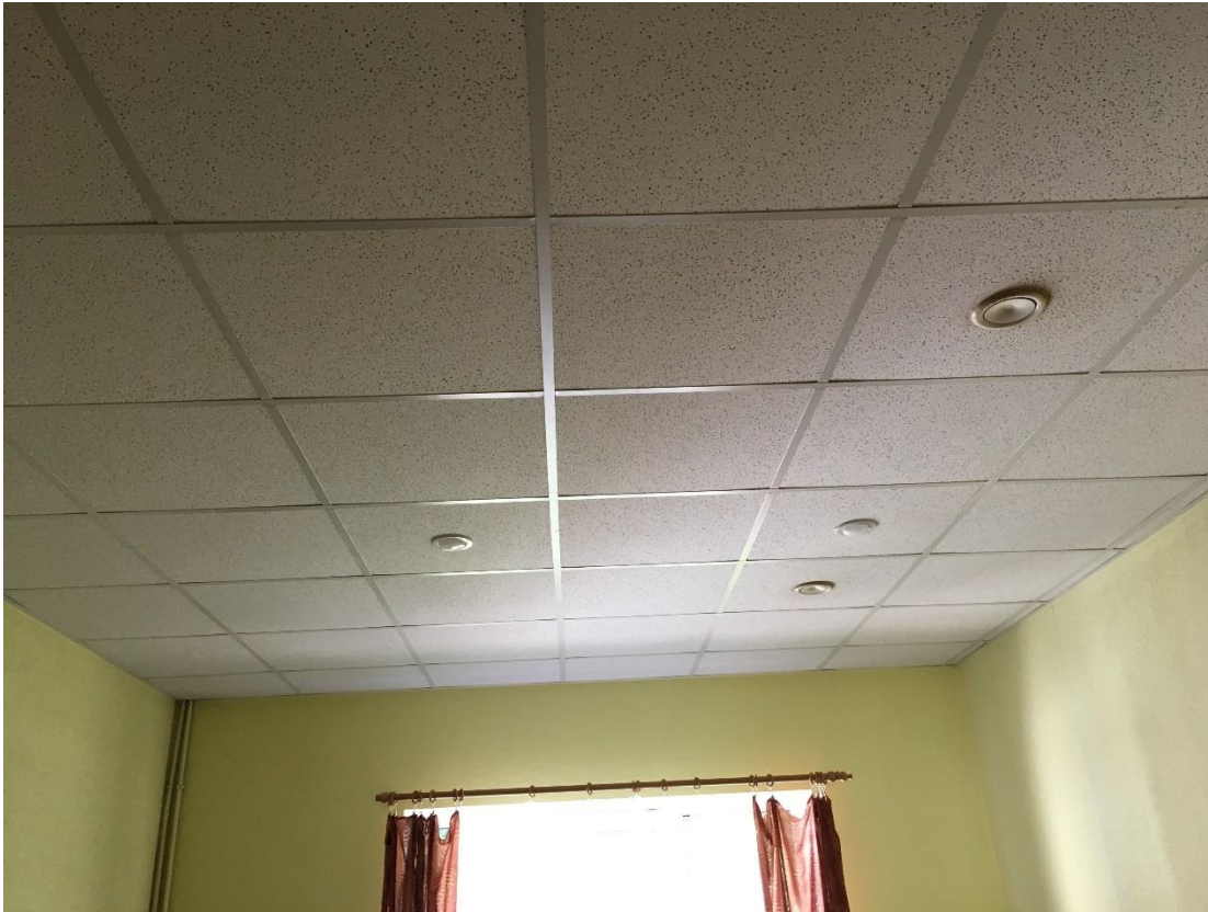
Att. Nr.11 Ventilācijas difuzori griestos
