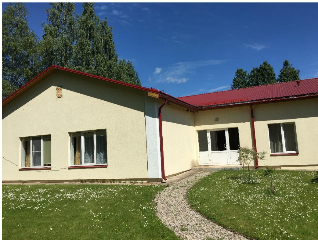
Att. Nr.2 Ēkas rezerves izeja
