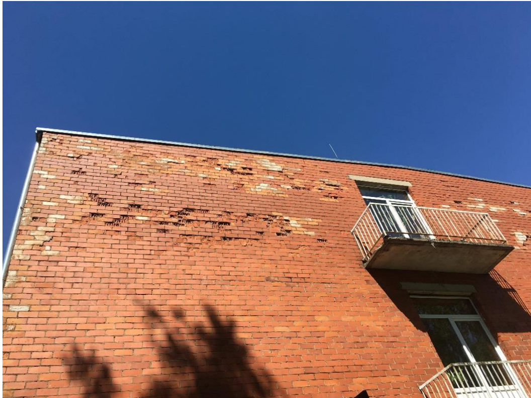
Att. Nr.2 Nodrupusi fasādes ķieģeļu virsma. Atsevišķu vietas jau pārmūrētas.
