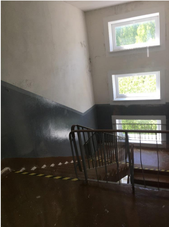
Att. Nr.9 Rezerves kāpņu telpa
