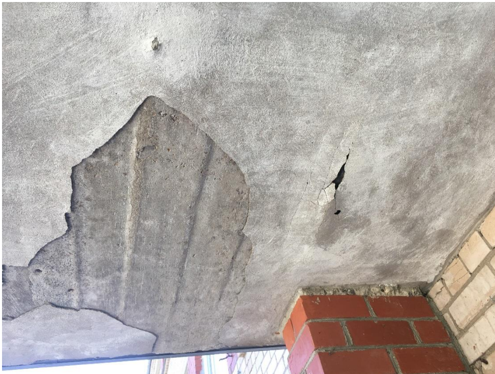
Att. Nr.8 lejas jūmiņa apmetums atlupis – apdraud ēkas apmeklētājus
