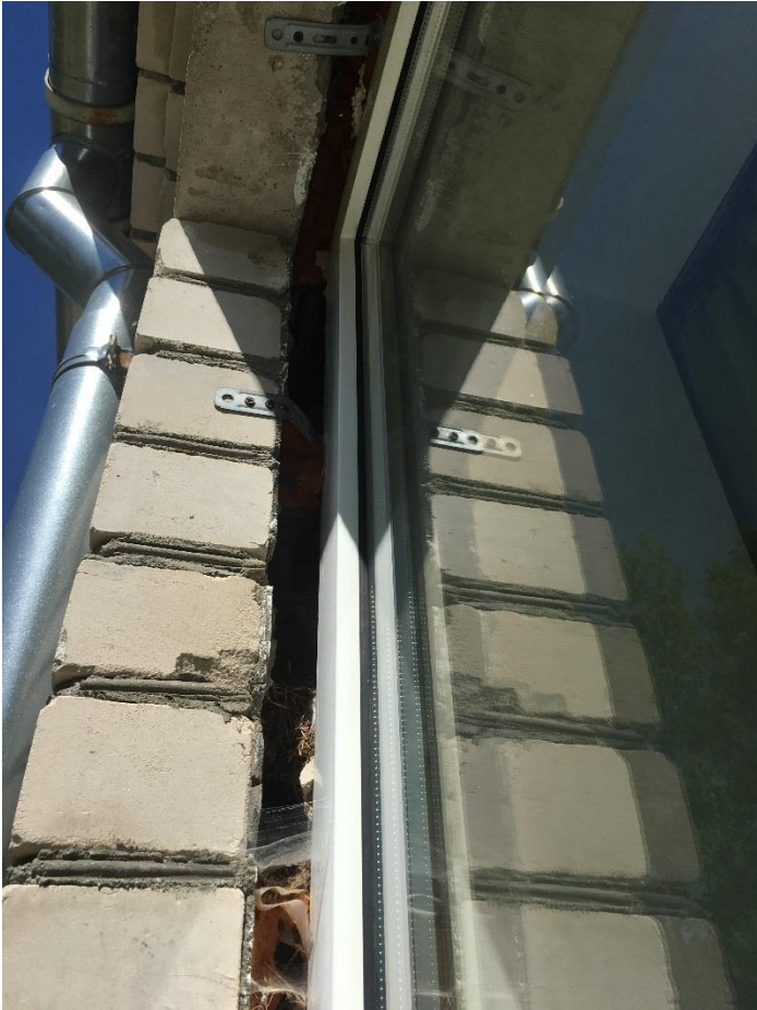
Att. Nr.5 Sprauga starp loga bloku un ķieģeļu sienu. Logu bloks iebūvēts neatbilstoši tehnoloģijai
