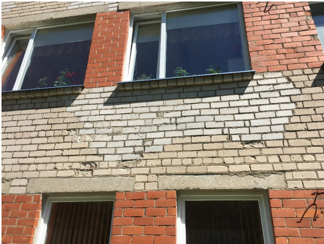
Att. Nr.2 Nodrupusi fasādes ķieģeļu virsma. Atsevišķu vietas jau pārmūrētas.
