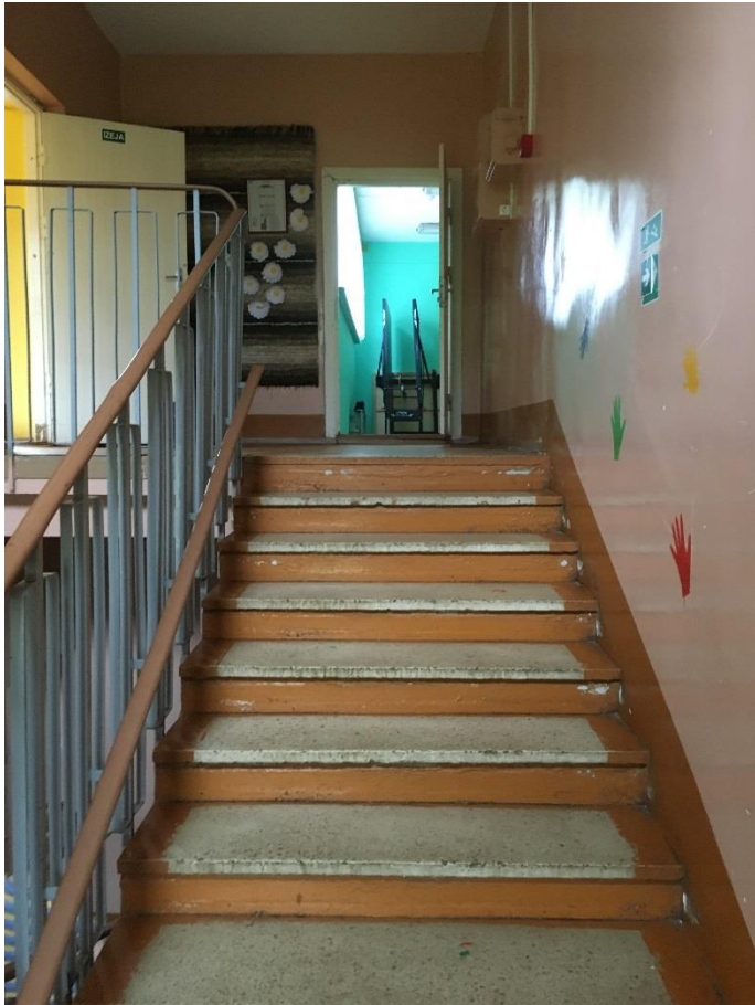
Att. Nr.15 Kāpņu telpa
