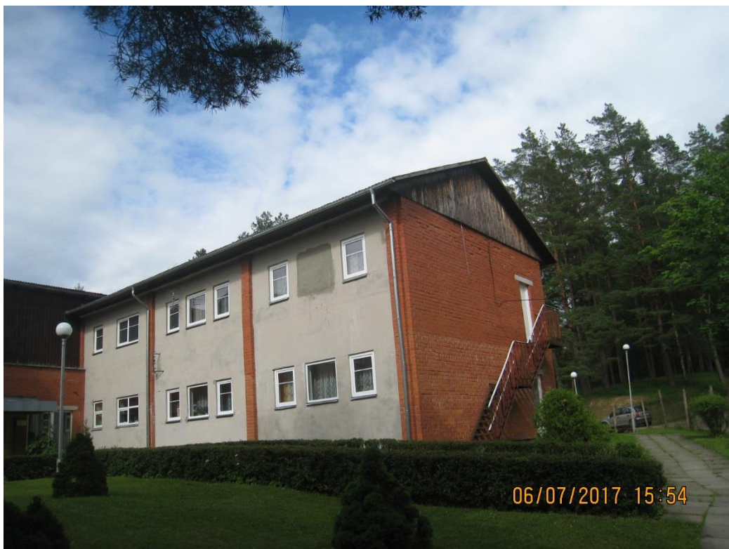
Att. Nr.2 Fasāde. 2.stāvā ir izvietoti zēni
