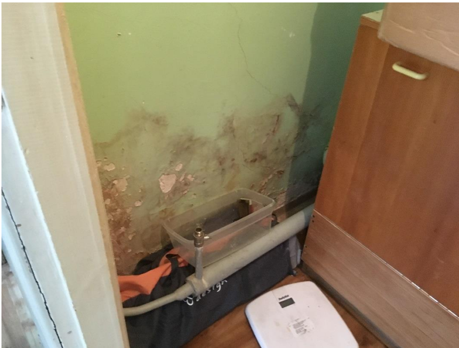
Att. Nr.14 Pelējums sienā, kurai otrā pusē ir dušas kabīne
