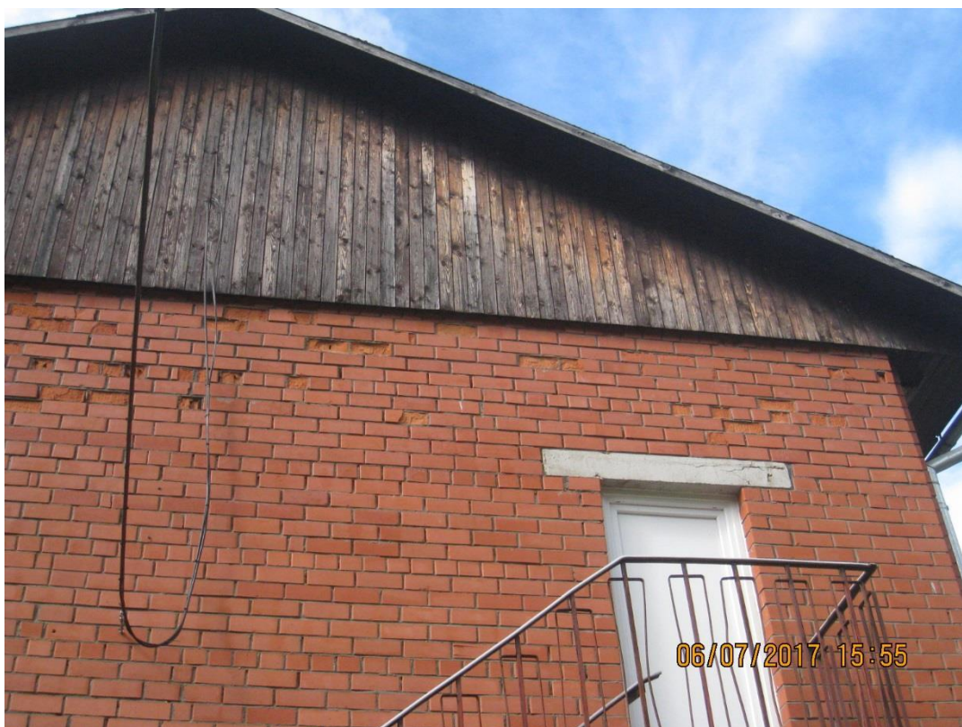
Att. Nr.5 Fasādes māla ķieģeļu virsma nodrupusi mitruma un aukstuma ietekmē
