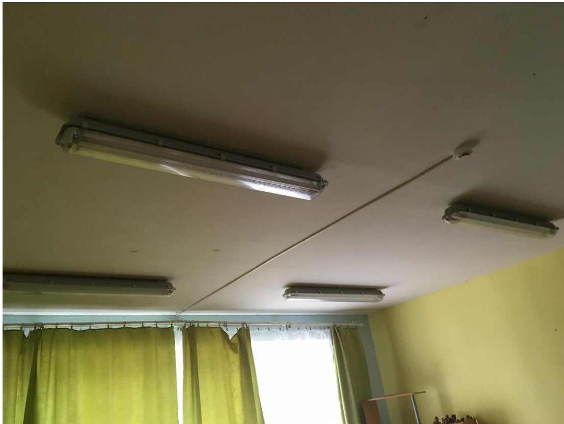
Att. Nr.23 Gaismekļi, ugunsgrēka atklāšanas sistēma – dūmu sensors
