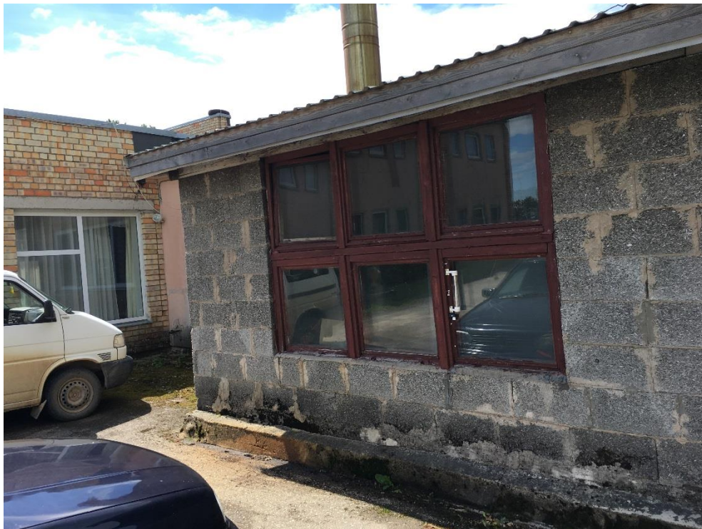
24. Katluteļpas fasāde – neapmests skaidbetons
