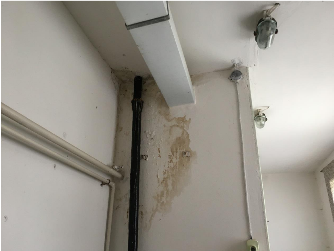
19. Nolijušas sienas kondensāta rezultātā 2.stāvā
