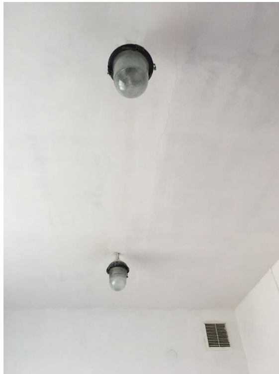
22. Gaismekļi santehnikas mezglā un dabīgās vēdināšanas reste
