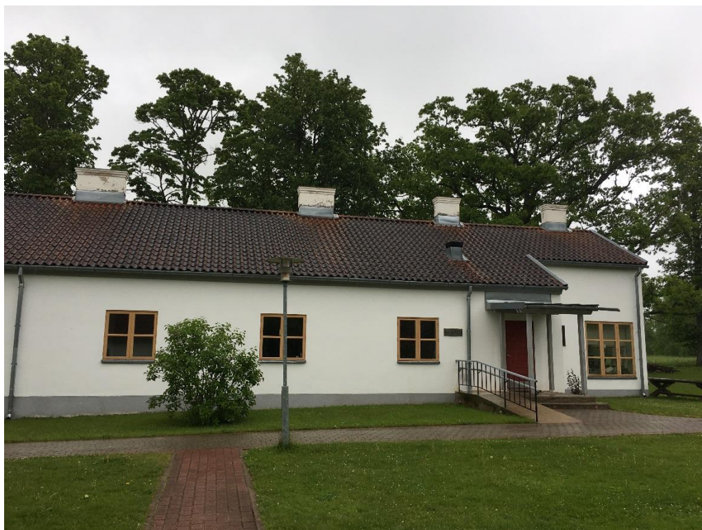
Att. Nr.2 Fasāde. Ieejas mezgls ar invalīdu uzbrauktuvi
