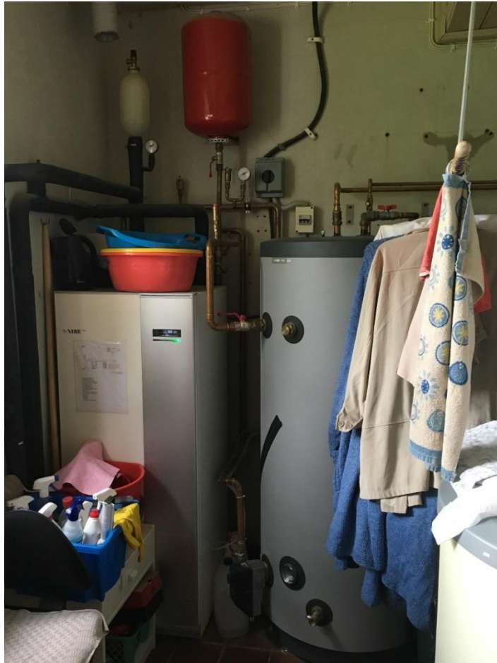
Att. Nr.15 Ģeotermālais apkures katls, karstā ūdens rezervuārs
