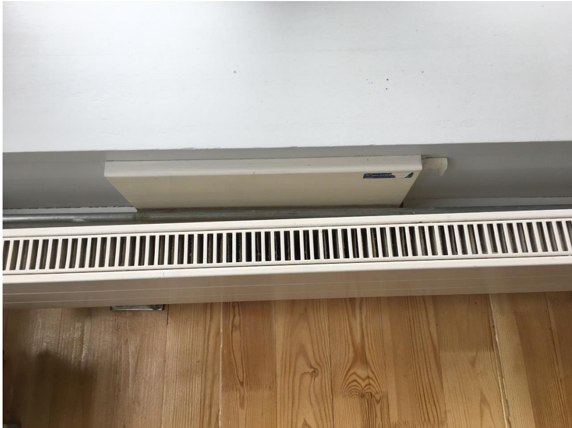
Att. Nr.11 Gaisa pieplūdes kanāla vārsts ārsienā pie radiatora
