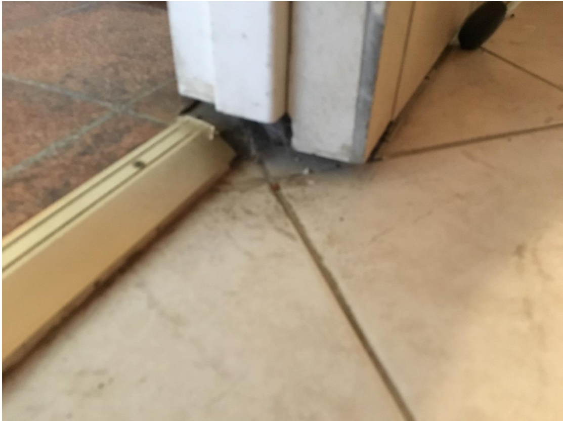
Att. Nr.7 Grīdas konstrukcija nosēdusies – sprauga starp grīdas flīzi un grīdlīsti vismaz 1cm
