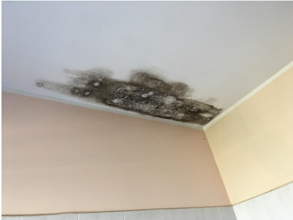
Att. Nr.23 Pelējums sanitārā mezglā griestos ģimenes mājā "B"
