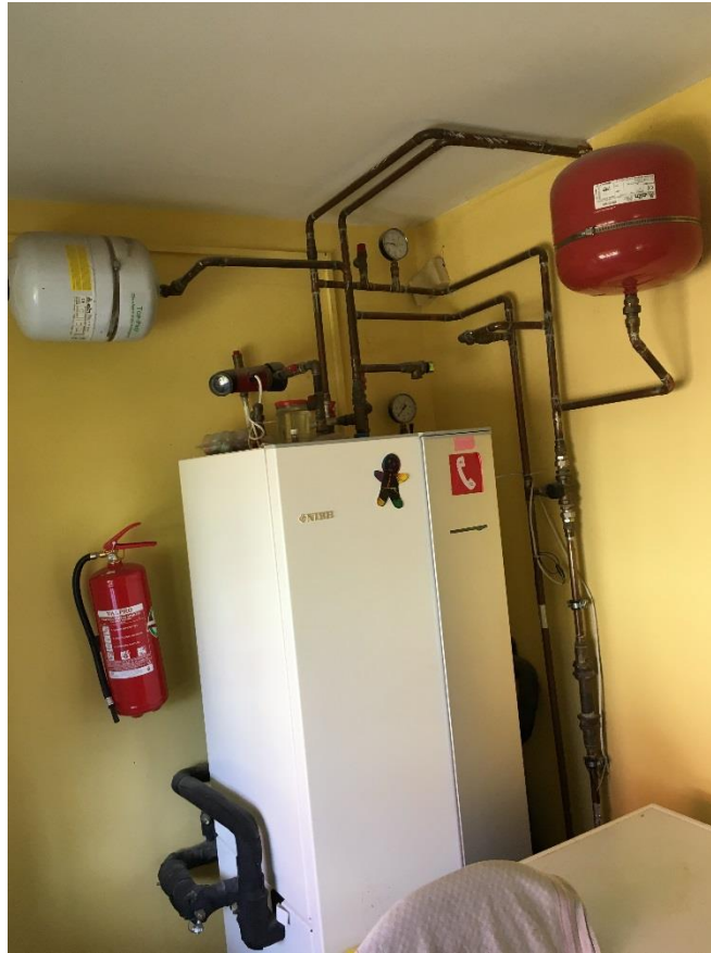
Att. Nr.11 Ģeotermālās sistēmas apkures katls
