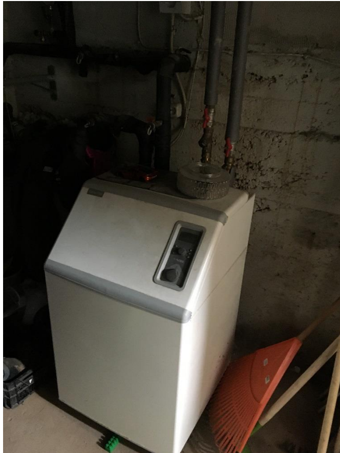
Att. Nr.21 Ģeotermālās sistēmas apkures katls
