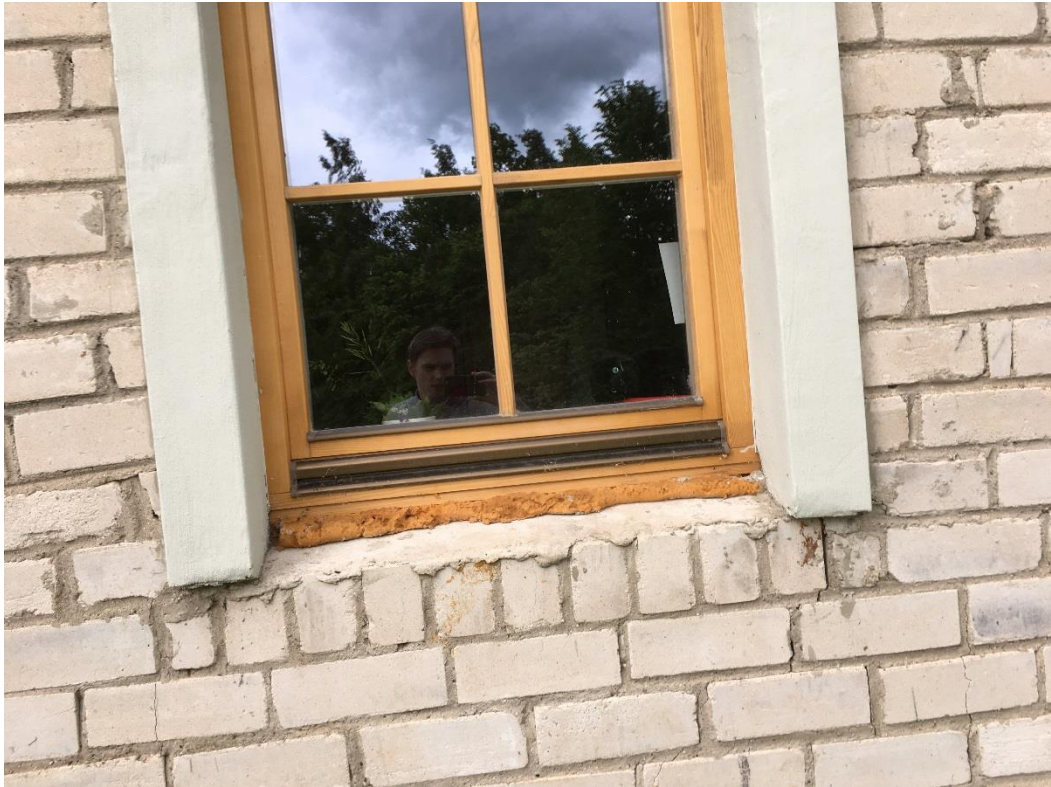
Att. Nr.31 Logam nav uzstādītas palodzes
