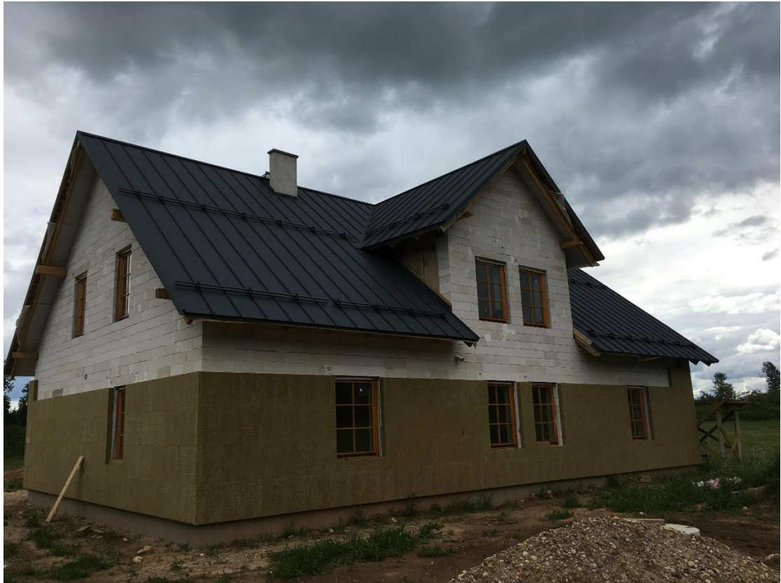
Att. Nr.33 Jaunbūve būvniecības laikā
