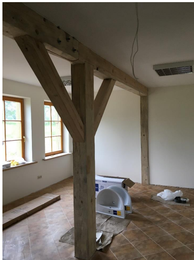
Att. Nr.34 Iekštelpas jaunbūvē būvniecības laikā
