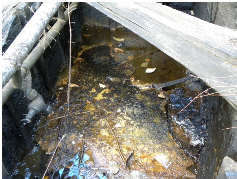
Attēls Nr.11. Vizuāli nosakāms piesārņojums mazuta tvertnēs Fotoattēla autors G.Grīnhofa
